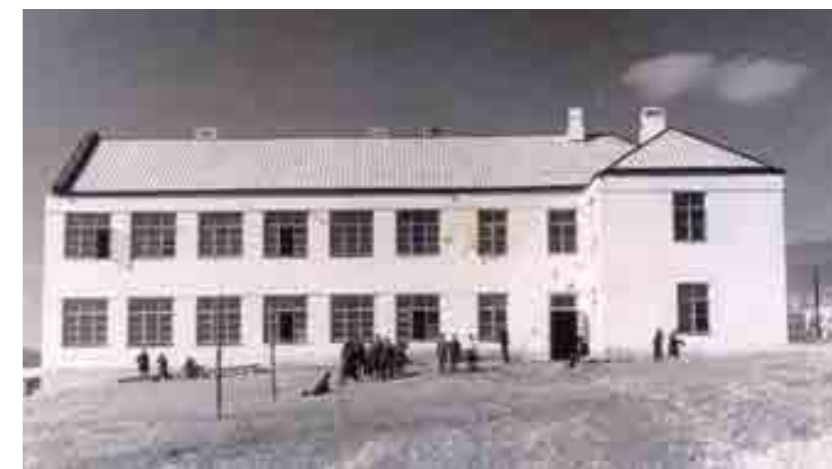
Рисунок 1. Школьное здание, построенное в 1932 году (вид с восточной стороны)
